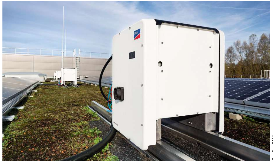
Bild 2: Der Wechselrichter »Sunny Tripower Core1« für maximal zwei Strings kommt ohne DC-Sicherungen aus
