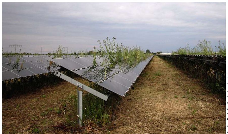
Bild 3: Nach einigen Jahren Betrieb kann man bei Freiflächenanlagen oft nicht mehr von einem »nicht brennbaren Untergrund« sprechen
